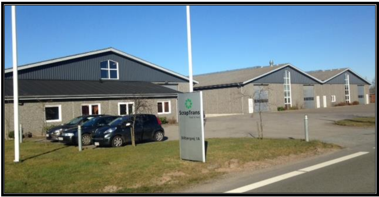
ScrapTrans A/S administration og fabriksbygninger
